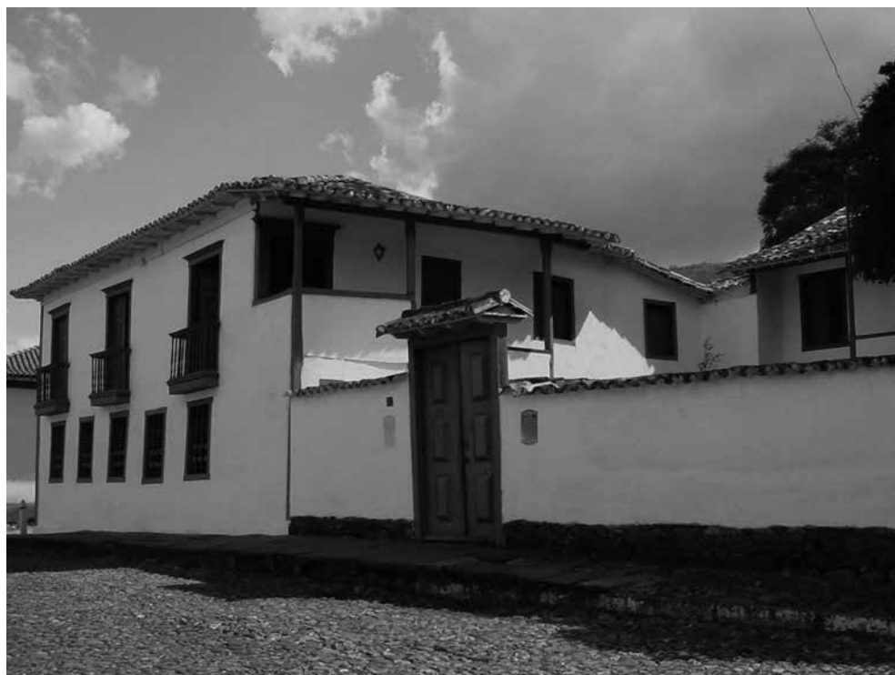
Figura n.º 1 – Fachada do Museu do Ouro, antiga Casa de Fundição e Intendência de Sabará, Minas Gerais, Brasil. Fonte: Arquivo Museu do Ouro, 2008.
